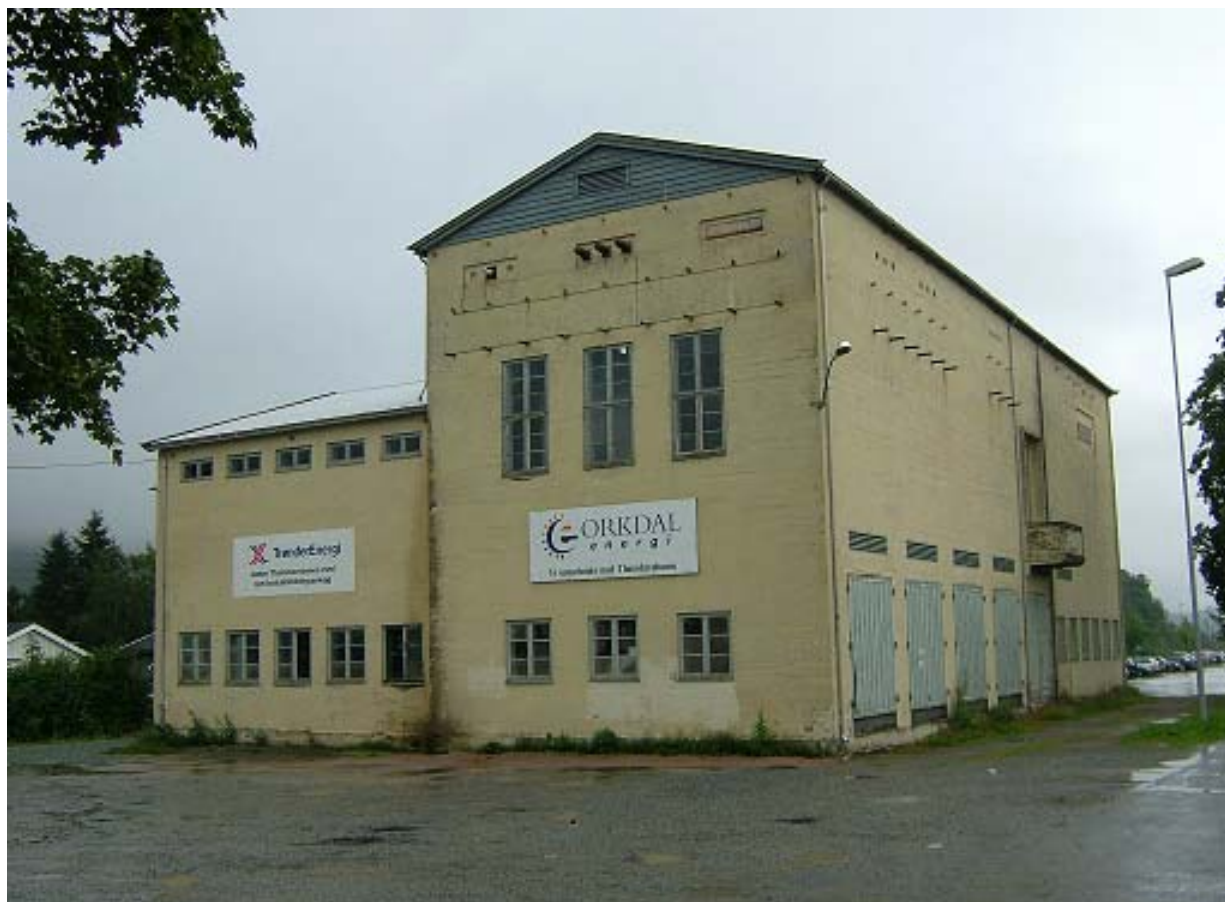
Omformerstasjonen på Bårdshaug fra 1945 er fortsatt i bruk
