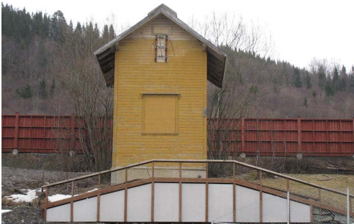
Transformatorhus nord for Orkanger stasjon
